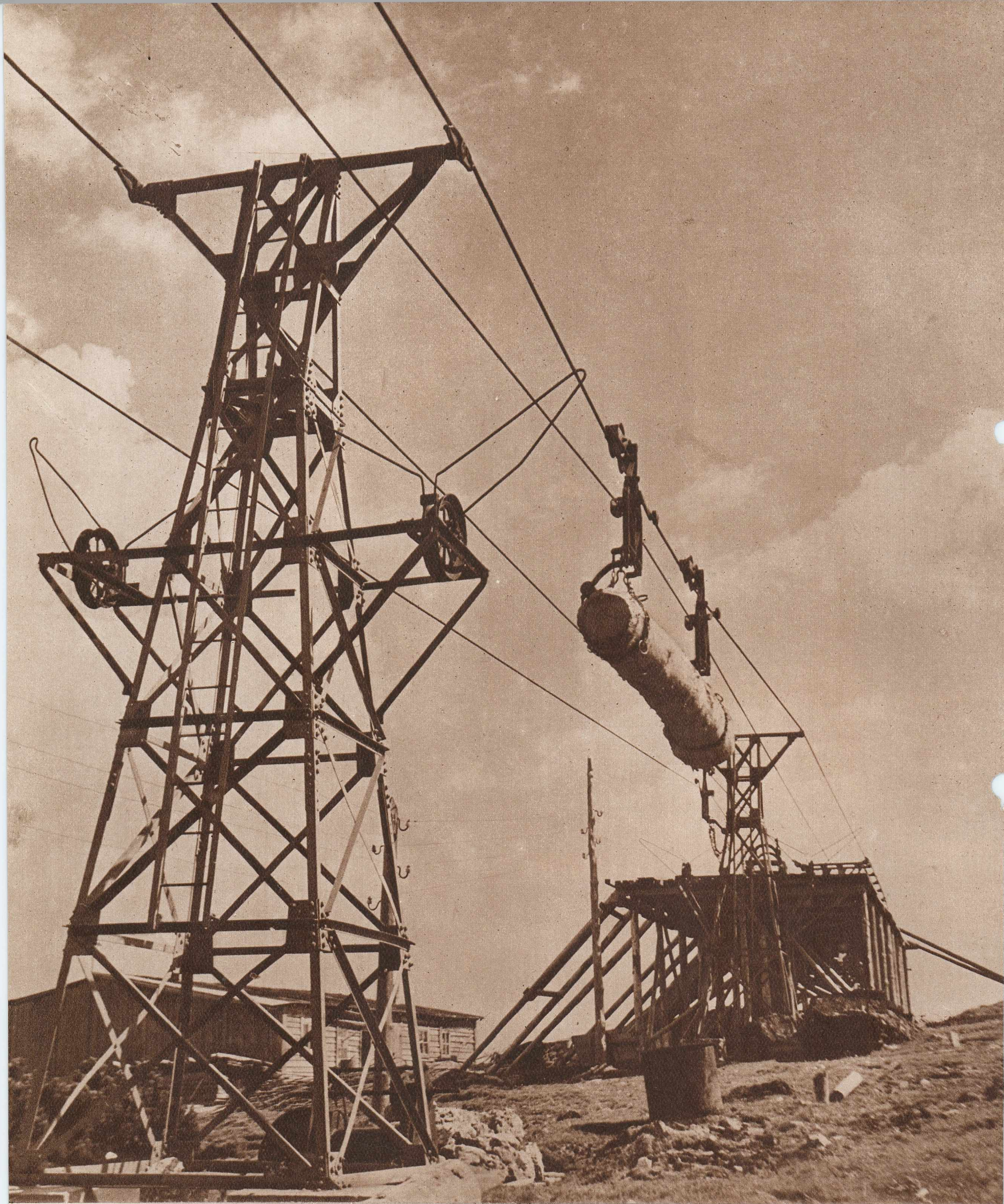
Cu funicularul, peste crestele munților, buștenii sînt coborîți din codrii Bucegilor, în vale, la fabrică.
