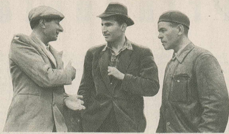
Inginerul-șef de șantier Zemora Victor discută cu meșterul Malek Niculae și cu Șulianu Mihai, meșter sudor, probleme legate de atelierul de prefabricate.
