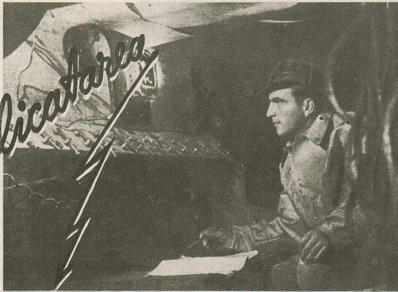
Executarea unei măsurători electrice în mină, în timpul electrosilicatării.
