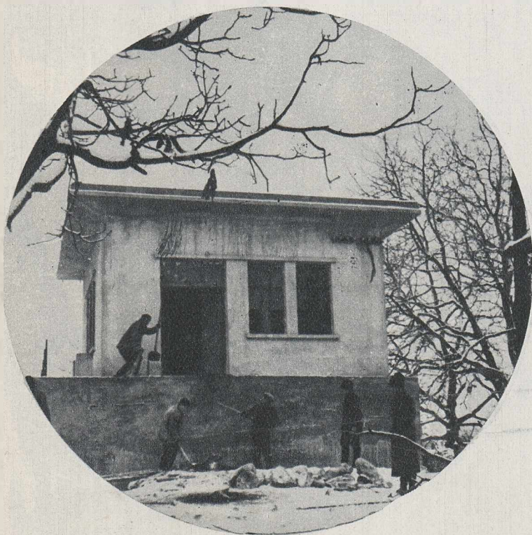
Finisarea hidrocentralei din Runcu.
