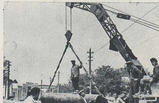
Instalarea conductei se apropie de sfîrșit. Artera de fontă se introduce pe străzile orașului.
