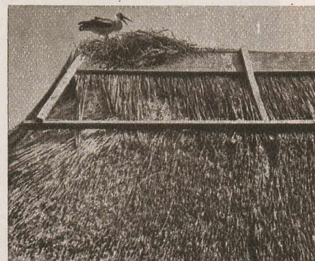
Un acoperiș de stuf!
