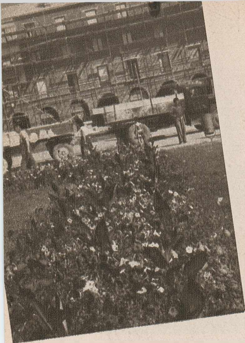
Încă n-au fost coborâte schelările și pe șantierul Grivița Roșie au și apărut spațiile verzi, cu flori încântătoare.
