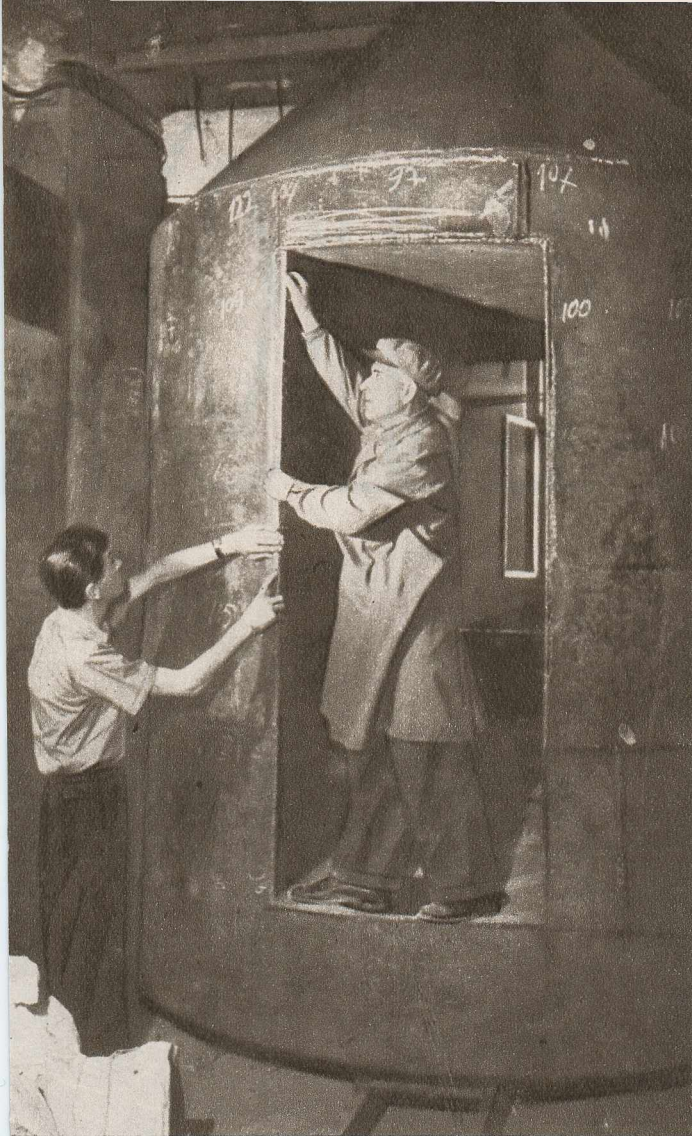
Sunt examinate cu grijă sudurile marii uși cilindrice cu lanță.
