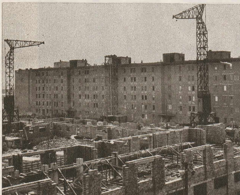
De șantierul celor 2000 de apartamente ce se construiesc în cartierul budapestan Lágymányos. Prin folosirea elementelor prefabricate, se scurtează timpul de construcție cu 80%. Până acum au și fost predate locatarilor 220 de apartamente, iar pînă la 1 decembrie vor fi predate încă 194.
