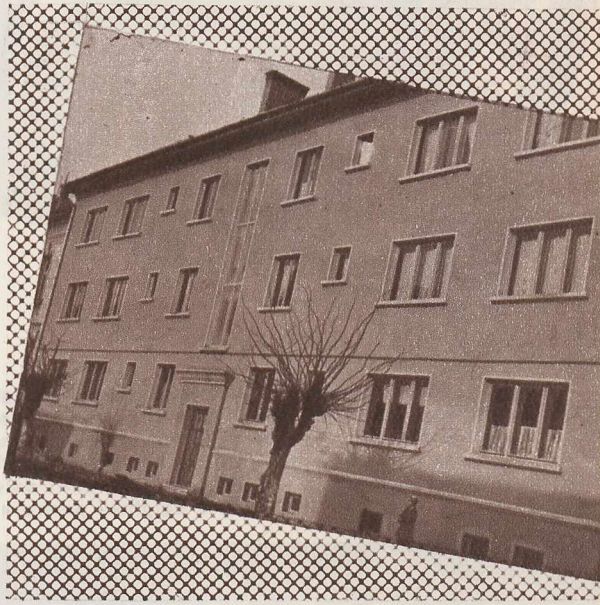
Cîtera din cele 155. Blocul de locuințe nou construit în strada Crișan.
