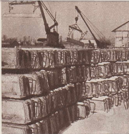
Intreprinderea nr. 8 de prefabricate. Aci se produc elementele prefabricate necesare construirii noulor blocuri muncitorești, precum și băncile și gardurile din parcuri și piețe.
