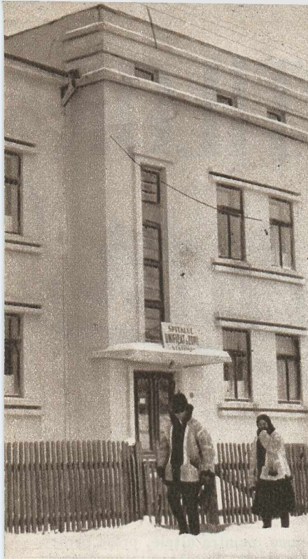
Clădirea Spitalului Unificat de copii
