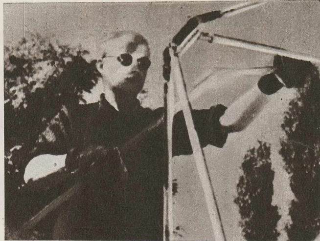
SOARELE TOPEȘTE OTELUL. Folosirea energiei solare în scopuri practice formează obiectul unor cercetări intense ale savanților sovietici. Paralel cu construcția primei centrale industriale solare în Armenia Sovietică, se desfășoară lucrările experimentale la Institutul de Energetică din Tașkent. Iată o oglindă parabolică specială, fabricată la acest institut, cu ajutorul căreia razele solare topesc oțelul.
