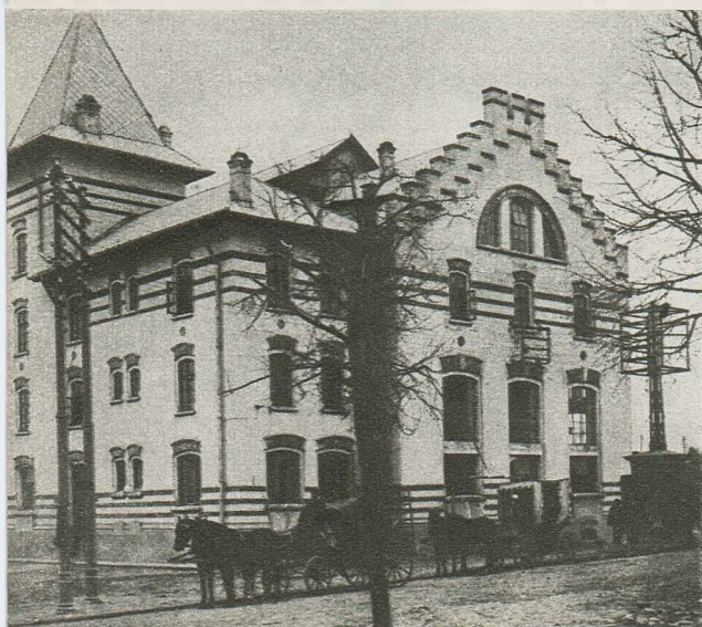
Centrala electrică de la Botoșani în anul 1913.
