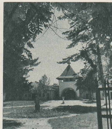
IN FOSTUL PALAT AL GOLEȘTIILOR, restaurat de curînd, s-a deschis Muzeul regional Pitești — secția 1848. Construit în anul 1640 de meșterul român Stoica, fostul palat a adăpostit în anul 1826 prima școală cu predare în limba română (aripa din stînga), bolnița și casa săracilor (aripa din dreapta). În centru se mai păstrează și azi foșorul în care dușmanii poporului l-au arestat pe Tudor Viadimirescu.
