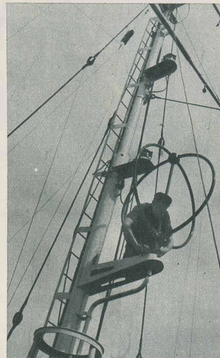
INCA UN SUCCES al șantierelor navale din G. Construirea remorcherului de 1.200 c.p. Instal. montează antena radiogoniometrică de pe remorcher care va brăzda în curind apele.
