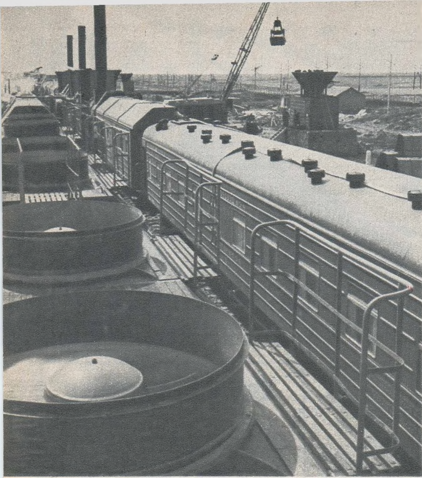
Colaborarea frătească este unul din factorii care asigură dezvoltarea neîntreruptă a științei și tehnicii țărilor socialiste. Iată o vedere parțială a celei mai mari stațiuni electrice mobile din R.P. Chineză, intrată de curind în funcțiune la Harbin. Ea a fost construită cu ajutorul tehnicienilor sovietici și cehoslovaci.
