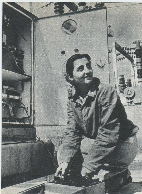
Utemista Lucia Timofte verifică o celulă de protecție de la stația de 35 km.
