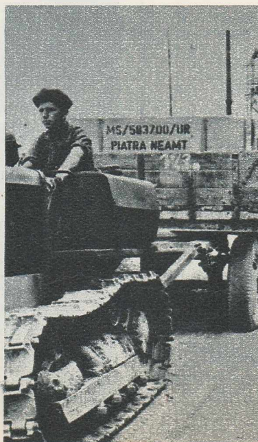
De la gară sosesc ultimele mașini pentru a fi instalate.
