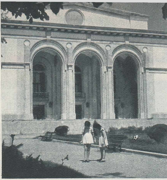
Fațada Teatrului de Operă și Balet din București și-a schimbat înfățișarea: s-a îmbrăcat în straie de marmură.
