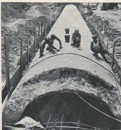
CARTIERELE 23 AUGUST, DUDEȘTI-CIO- PLEA; VATRA LUMINOASĂ vor fi deservite, prin L. cul Tei, de un nou canal coteștor de cana- lizare. Este o lucrare însemnată pe care Trus- tul de construcții hidraulice a început-o în apro- pierea podului Vitan din Capitală. Canalul va avea o lungime de 8500 m dintre care 1300 m vor fi terminați încă în anul 1958.
