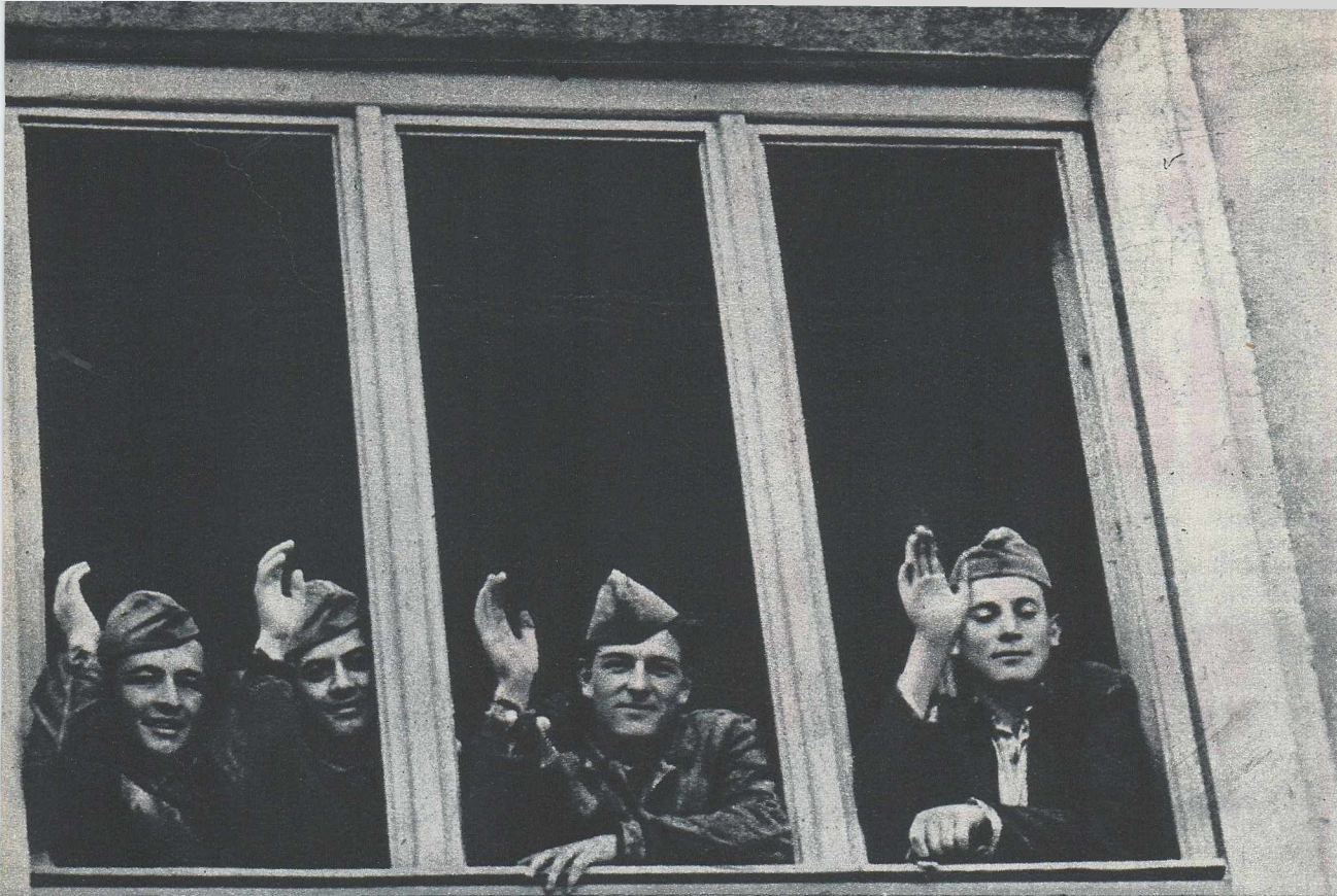
De la fereastra unui apartament în construcție, vă salută cîțiva brigadieri de pe șantierul tinarelui, care s-a inaugurat la 28 septembrie.
