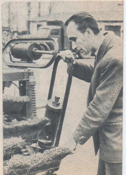
Ing. Gh. Bălan: „Chiar aici, în acest colț al „automăturătorii”, sînt o serie de lagăre care ar putea fi fabricate din mase rășinoase, în loc de metal”.
