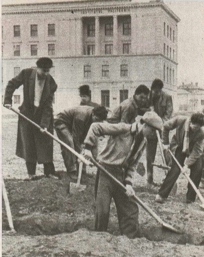
La muncă patriotică, pentru amenajarea parcului din fața noii clădiri a Institutului Politehnic.
