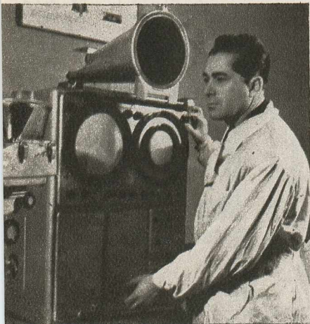
DIAGNOSTIC CU AJUTORUL... ULTRASUNELOR. La Institutul Unional de cercetări științifice pentru instrumente și utilaj medical din Moscova, a fost creat acest aparat care servește la nisticarea tumorilor. Cu ajutorul impulsurilor sonore, aparatul permite nu numai deosebirea unui obiect de tumoarea canceroasă, ci și operarea tumorii chiar la începutul imbolnă-
