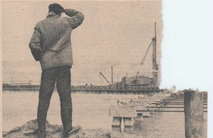
MARILE ȘANTIERE NAVALE DIN GDYNIA (R.P. Polonă), actualul curs de refacere, vor putea construi mari vase maritime ajungînd pînă la tone. În fotografie: aspect din timpul lucrărilor de reconstrucție a șantie
