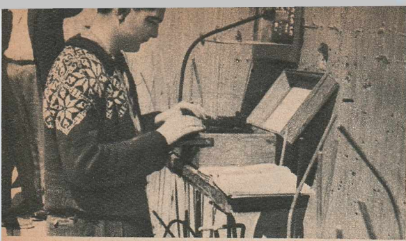
Una din cele 21 stații de măsură a barajului Tehnicianul Hatzak controlează cu teleohmmetrul fenomenele care au loc în masa de beton
