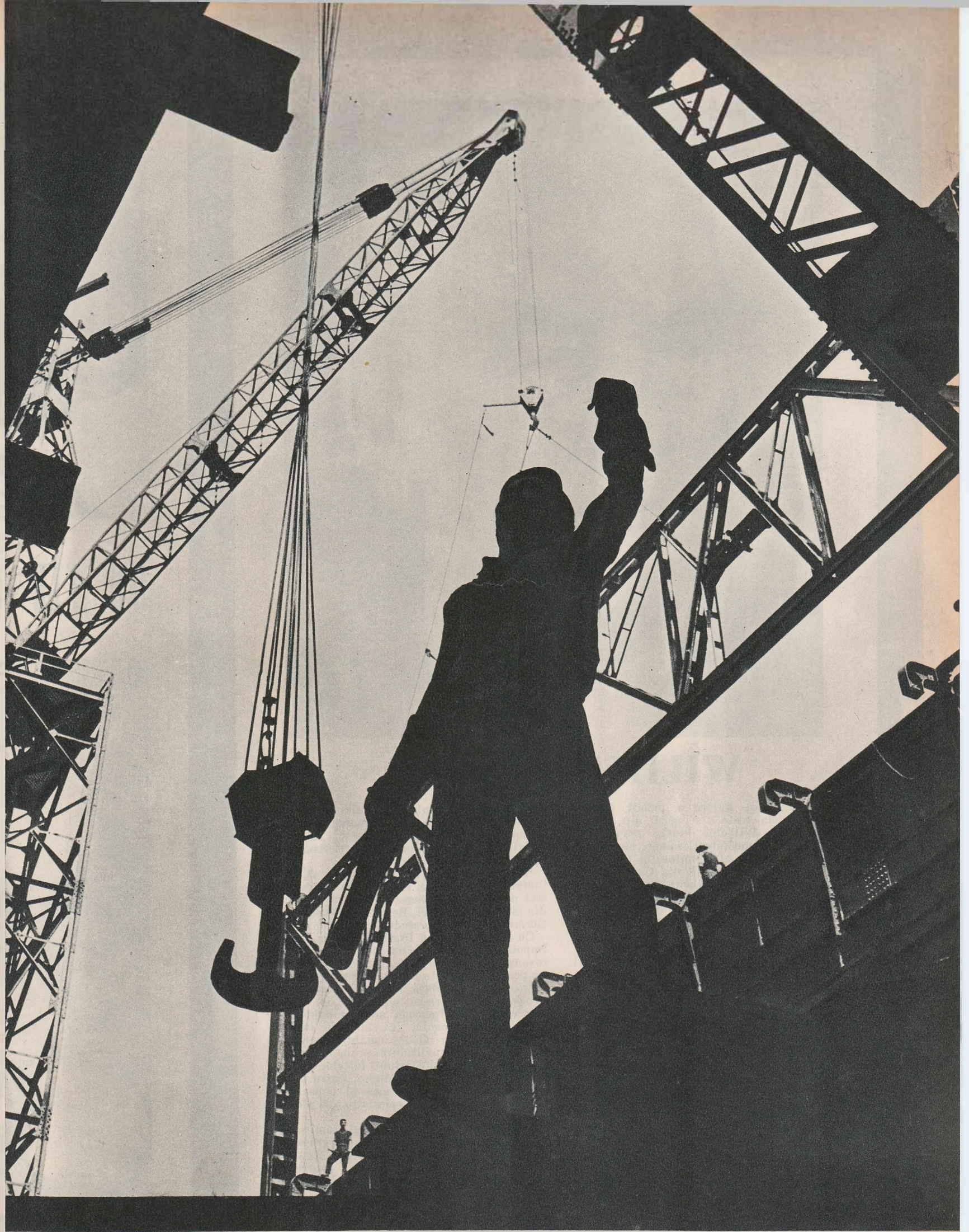
Montorii de la I.C.S. Hunedoara lucrează din plin la construirea cuptoarelor 5 și 6 de la oțelăria nouă. Nituitorul Bereschi Ludovic, pe calea de rulare a macaralei de 300 t pentru cuptoarele 4, 5 și 6.
