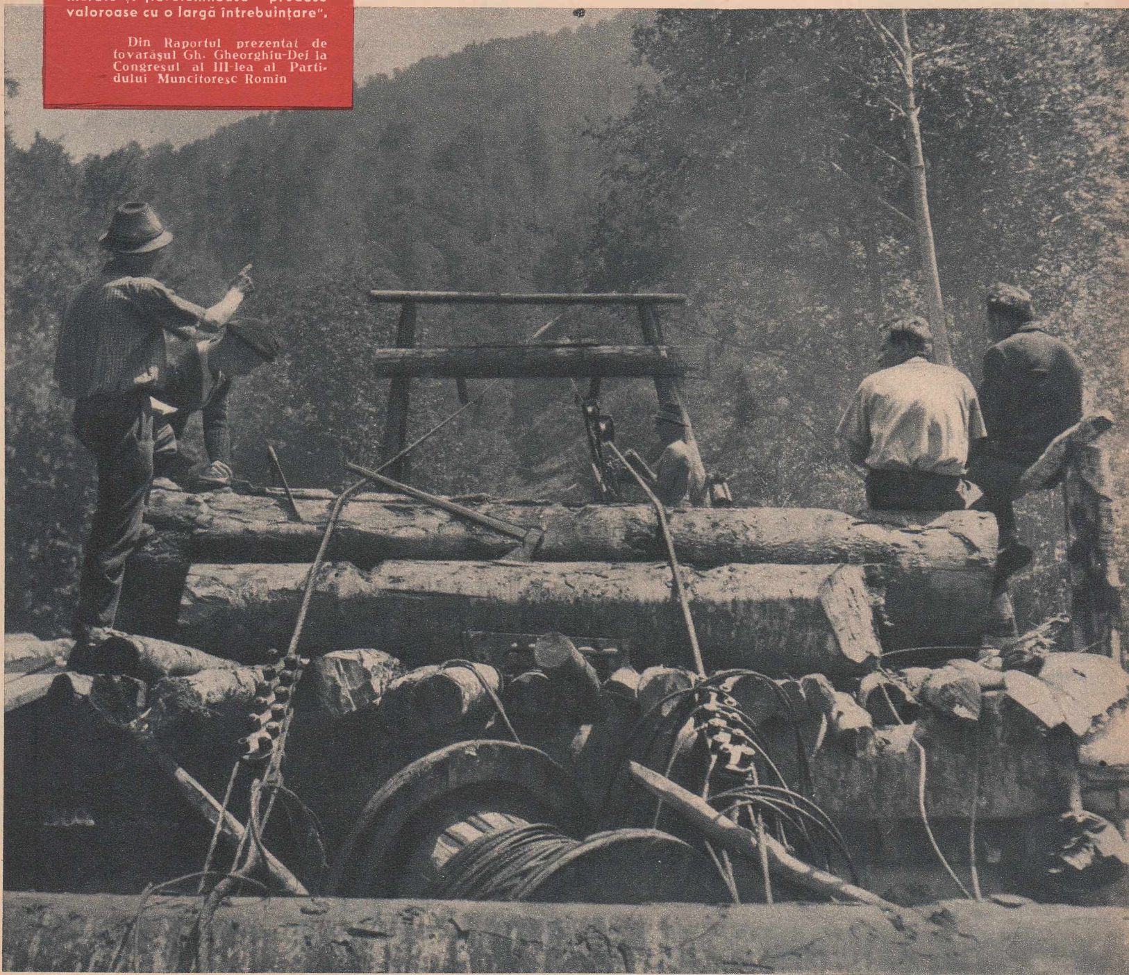
Rampa de încărcare „Repede IV”. Din înălțimile munților cablul de oțel coboară zilnic zeci de tone de bușteni care vor lua drumul fabricilor prelucrătoare.
