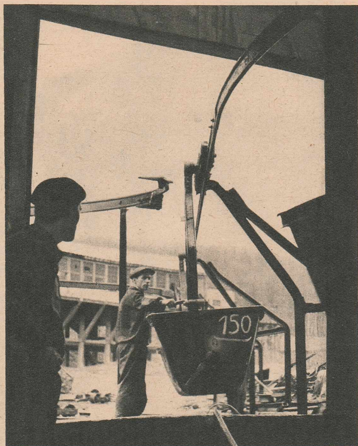
La 1.300 de metri altitudine: stația de concasare și silozul de la Lespezi. Înainte de a porni cu funicularul, piatra suferă aici prima operație: reducerea dimensiunilor. În primăvară va intra în funcțiune un al treilea concasor.
