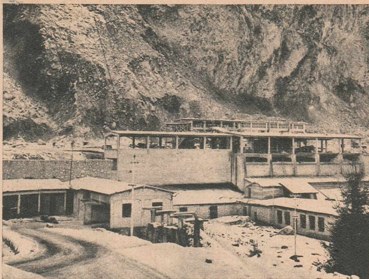
La 1.300 de metri altitudine: stația de concasare și silozul de la Lespezi. Înainte de a porni cu funicularul, piatra suferă aici prima operație: reducerea dimensiunilor. În primăvară va intra în funcțiune un al treilea concasor.
