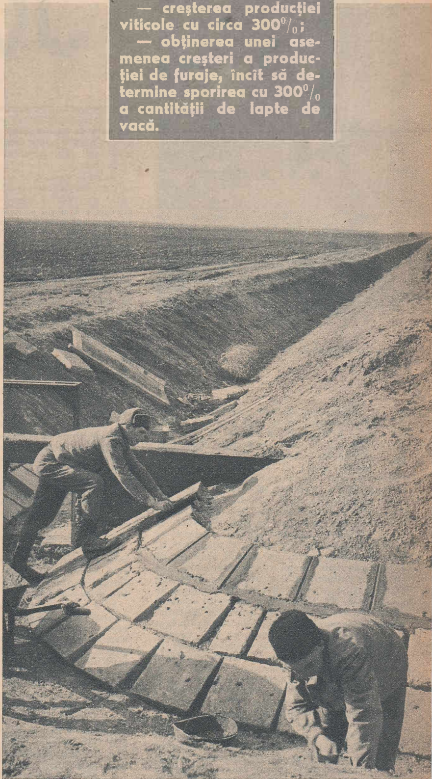
Finisarea lucrărilor de artă din apropierea stației de repompare.
