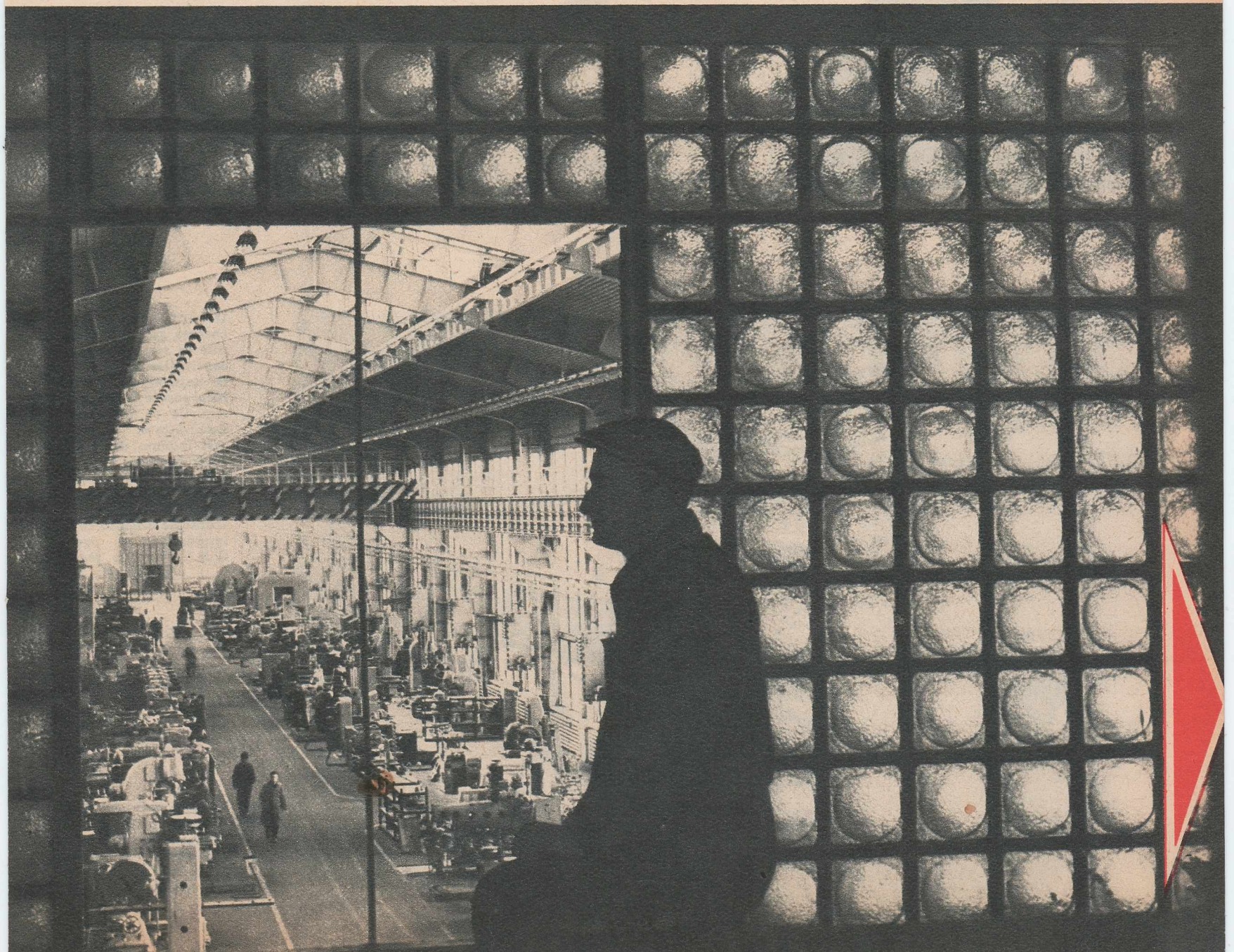
Utemistul Alexandru Craia de la „Electromotor” din Timișoara, lucrând la această mașină electronică de copiat arborii, care execută lucrări de mare precizie, contribuie la ridicarea calității motoarelor electrice executate aci.
