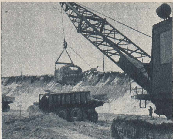
Lucrările de deschidere a minei Mihailovka, din zona anomaliei magnetice de la Kursk. Aici exploatarea se va face „la zi”, adică la suprafață.
