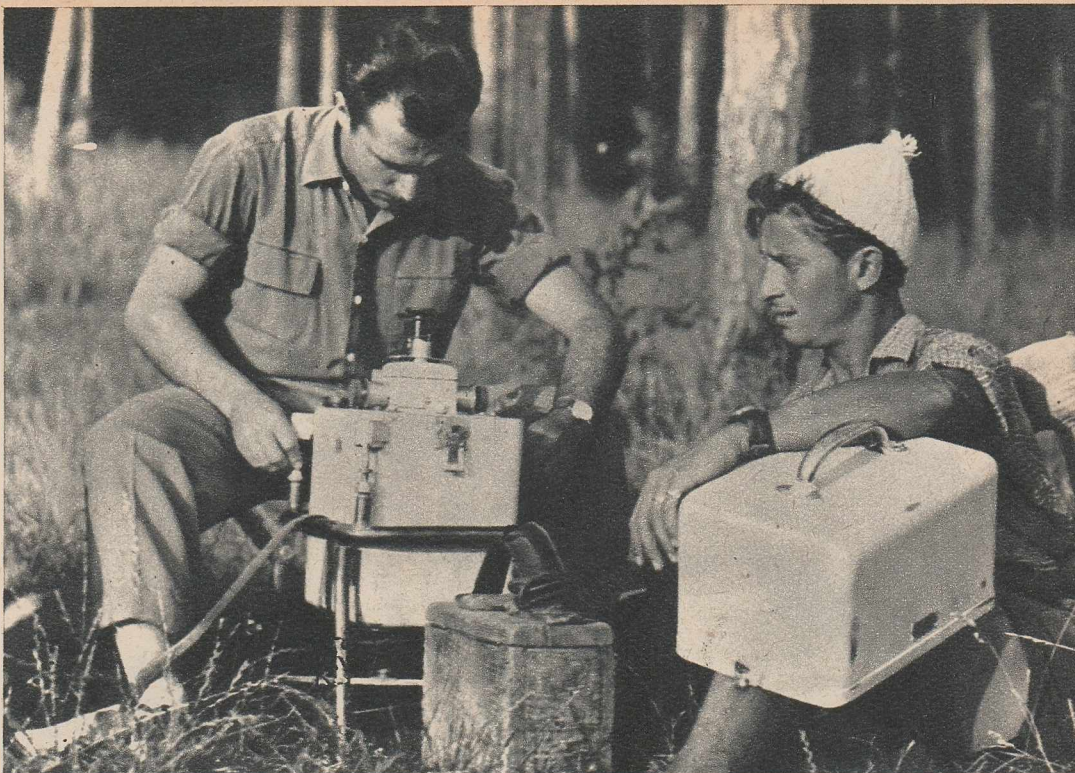
În căutarea zăcămintelor de minereuri aurifere în Munții Apuseni, cu ajutorul gravimetrului. Dimensiunile reduse ale aparatului ușurează considerabil munca pe teren.
