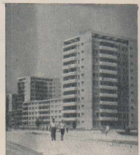
Pe locul unde pînă nu demult se afla vechea gară din Constanța, se înalță acum aceste blocuri turn. Construcțiile au și fost date în folosința noilor locatari. (B. Petreanu)
