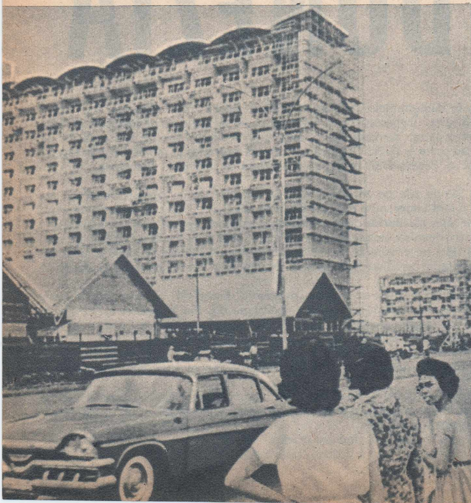
← Hotelul „Indonezia” face parte din construcțiile moderne ale capitalei Indoneziei.
