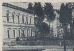
În fotografiile sus — vechea clădire în care școala a funcționat între 1863 și 1888; jos — clădirea ridicată prin contribuția comunelor în 1888, cărora în anii 1961-1962 i s-au făcut reparații capitale, restauratorilor respectîndu-l stilul arhitectonic inițial.
