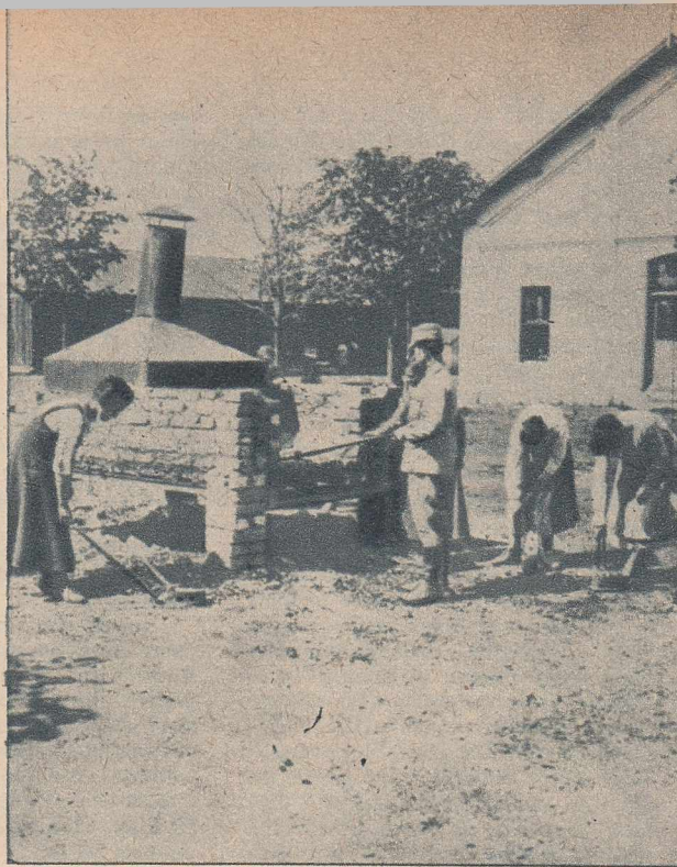
Cuptorul de unde cu peste 15 ani în urmă se făcea aprovizionarea cu cărbuni.
