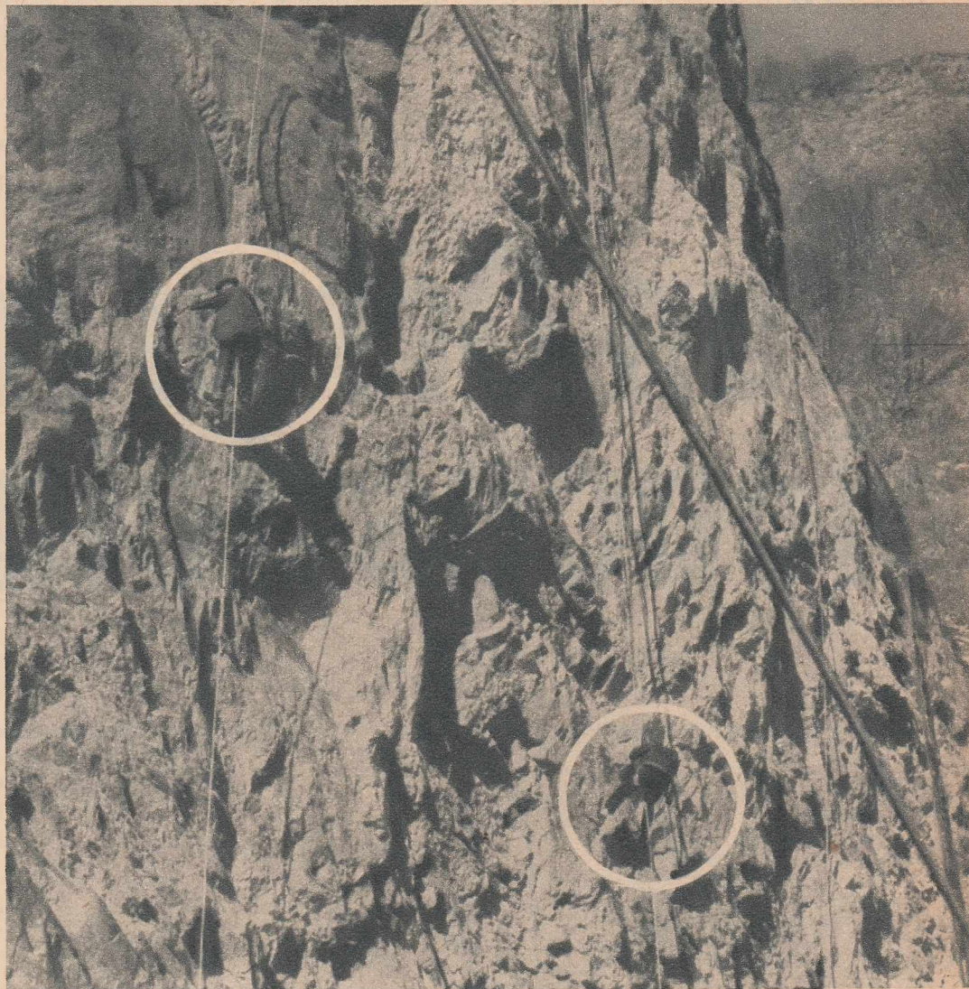
Lucrări de armare la traversarea aeriană de la aducțiunea principală (intrarea din Valea lui Stan).
