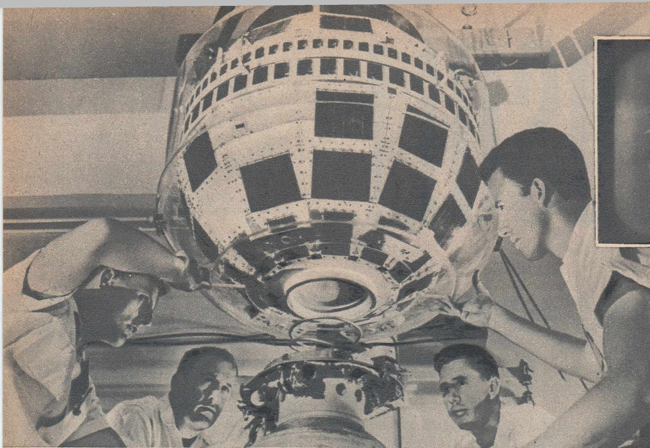
„Telstar” în curs de montaj (stînga) și în acțiune (sus) : o imagine televizată prin intermediul lui.
