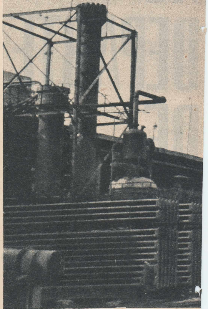
Duza de evacuare a gazelor de la Fabrica de acid azotic se înalță la 110 metri.
