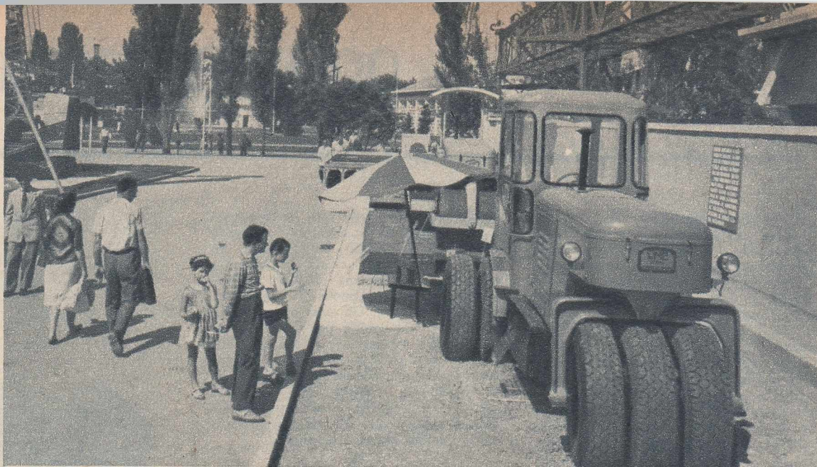
Alte utilaje moderne, fabricate în R.P.R., destinate șantierei de construcție.
