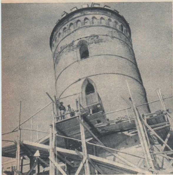
Turnul Chindiei a îmbrãcat haina provizorie a schelelor.
