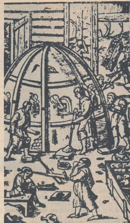
Așa arăta un mare atelier de fabricare a sticlei acum patru sute de ani. (G. Agricola : „De Re Metallica”, Băile, 1556.)
