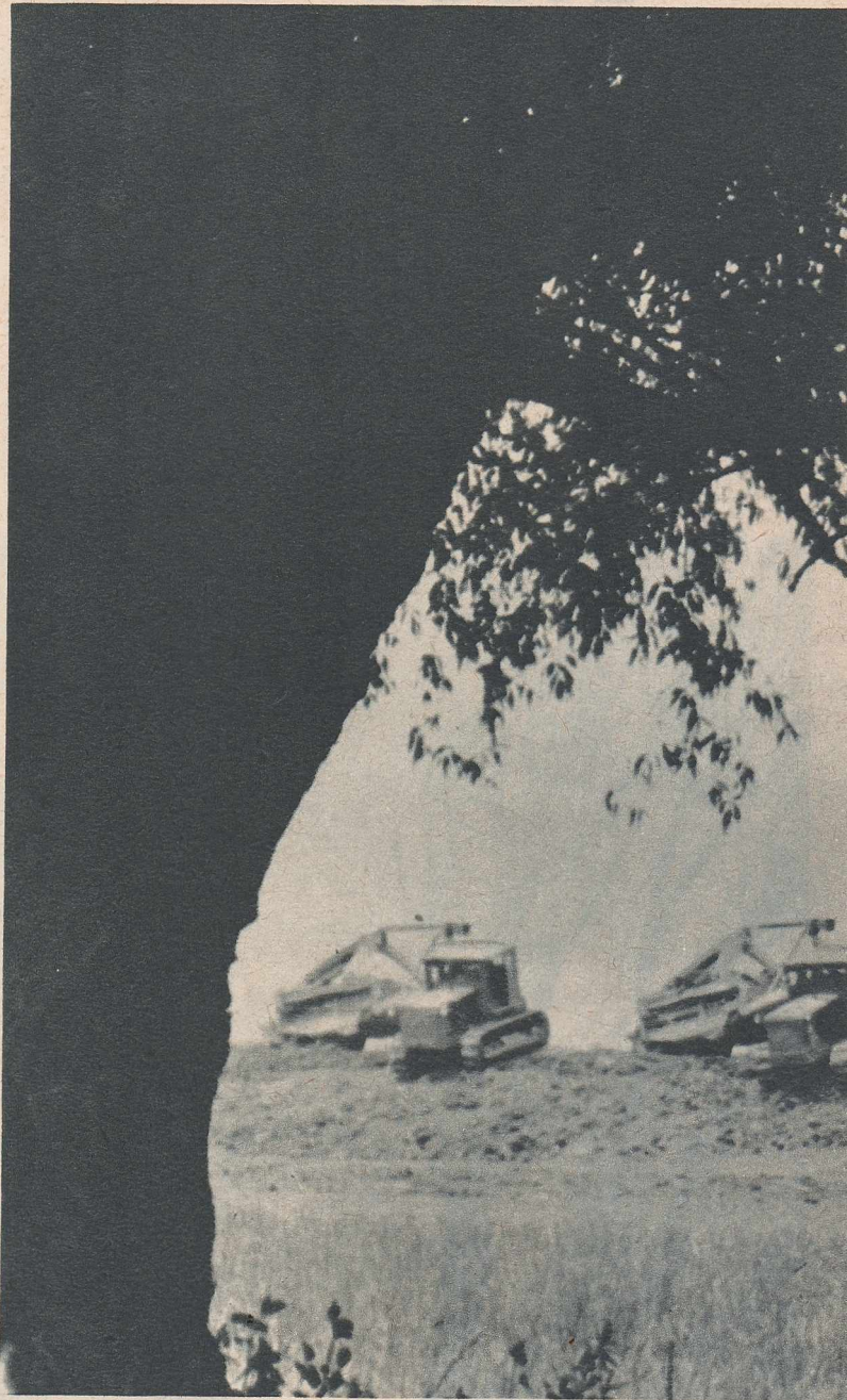
Armata de oțel a agregatelor moderne înalță o puternică stavilă împotriva apelor.
