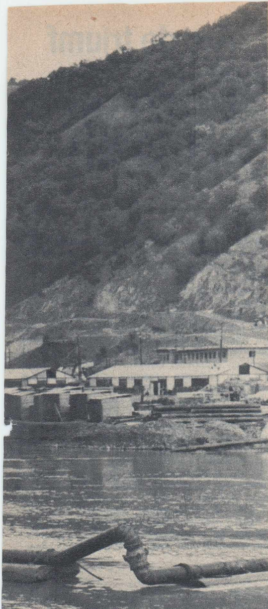
▲ Lucrări de dragaj în incinta șantierului.
