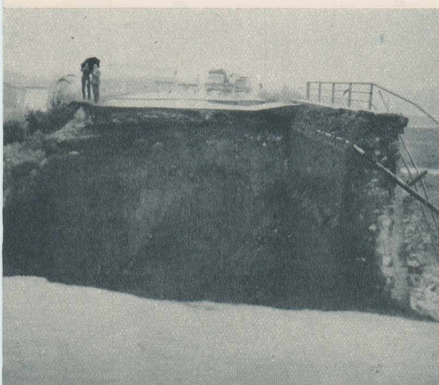
Dezastrul provocat de ploile și inundațiile din ultimul timp a cuprins numeroase regiuni din Italia, pagubele produse fiind foarte mari. Imaginea înfățișează un pod prăbușit la Prima Porta, o suburbie a Romei.
