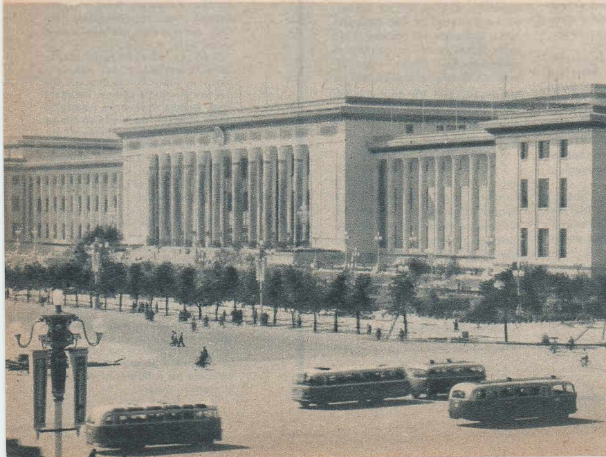
Palatul Adunării Poporului, situat în piața Tiananmin din centrul capitalei R.P. Chineze.
