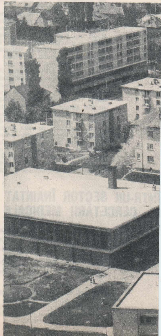
Cîteva din clădirile noului cartier al studenților din Timișoara.
