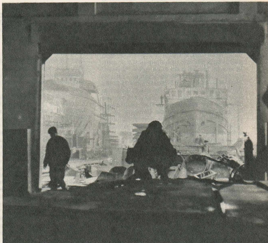
La Șantierul naval Oltenița, azi.
