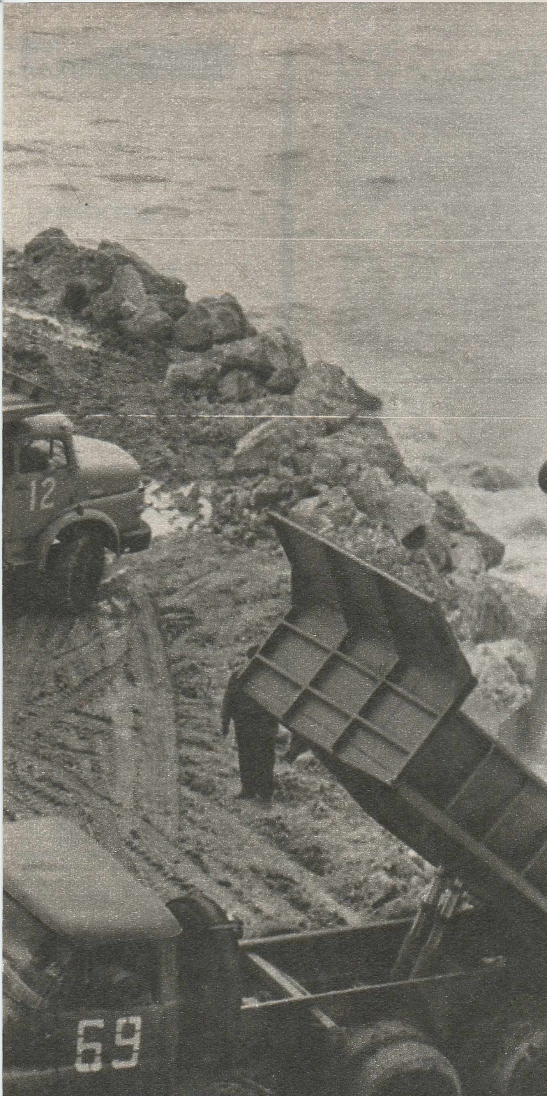
Aceste arătări apocaliptice nu-s altceva decit faimoșii stabilopozi. Fiecare cîntărește 20 000 kg. Cu ei se consolidează digurile viitorului port.
