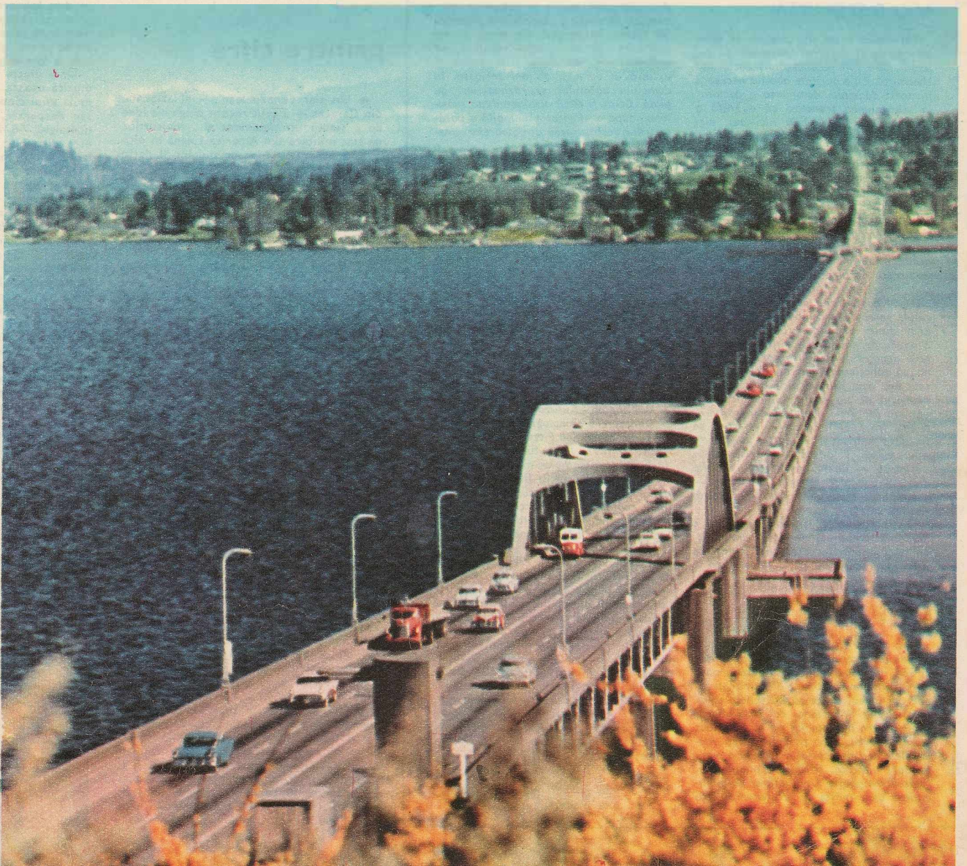
Evergreen Point Bridge, unul dintre cele mai mari poduri plutitoare din lume.
