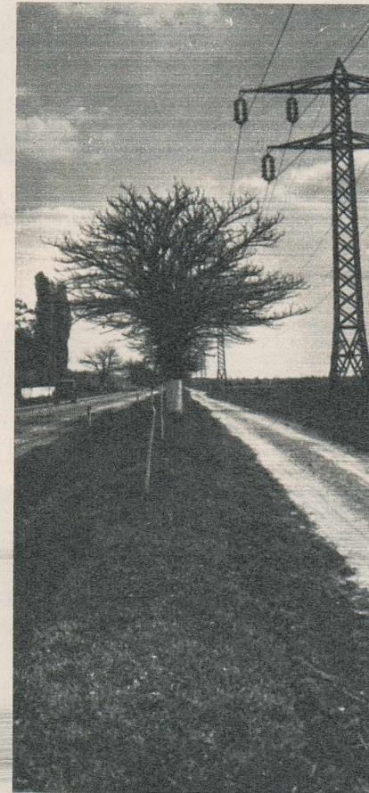
Așa, da! Linia de înaltă tensiune nu fură din terenul arabil. E paralelă cu șoseaua națională și e apropiată de marginea acesteia.
