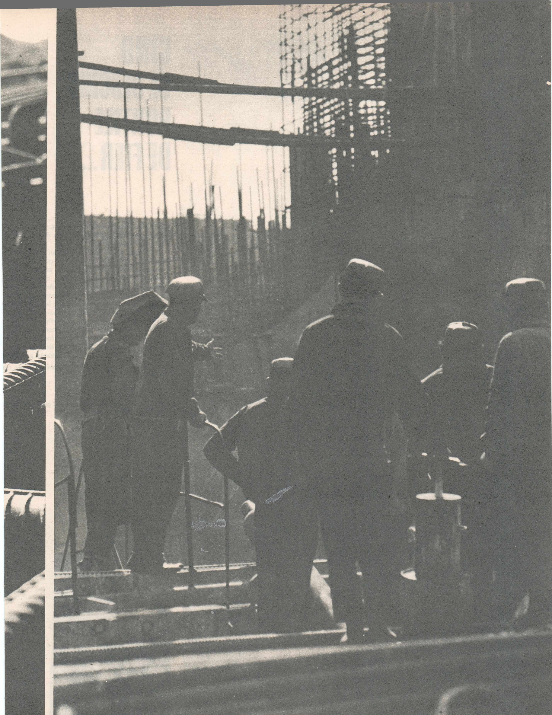
Se execută lucrările pregătitoare în vederea montării turbinei de 178 MW.
