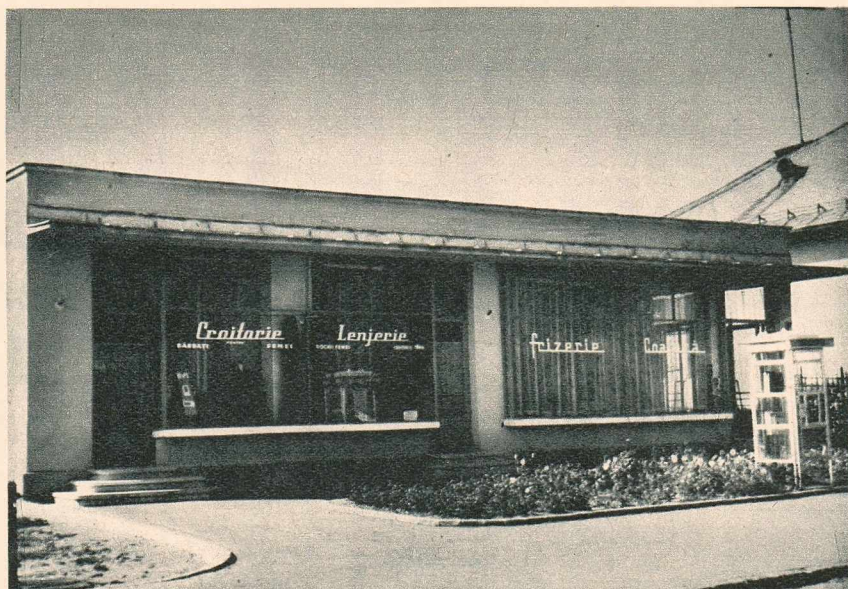
UNIREA: Complexul de deservire din strada Valea Roșie — Baia Mare.
