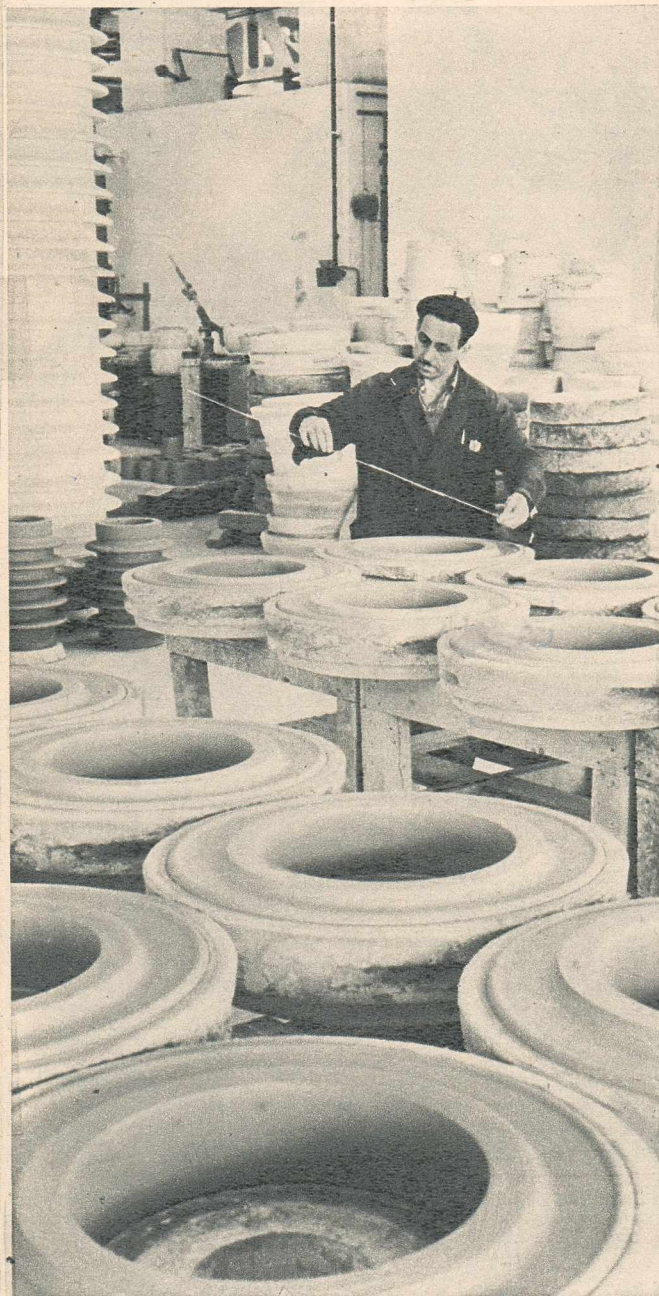
La «Electrocaramida»-Turda se fabrică izolatori pentru liniile de înaltă tensiune. În fotografie: o ultimă privire și rola vor pleca spre destinație.
